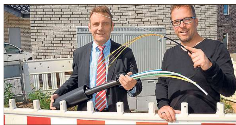
Strippenzieher in Aktion: Josef Breuers (l.), Breitbandbeauftragter im Festnetz der Deutschen Telekom, und Rüdiger Ropinski, Leiter der Abteilung Räumliche Planung der Stadtverwaltung Rietberg, zeigen das Muster eines Glasfaserkabels.
