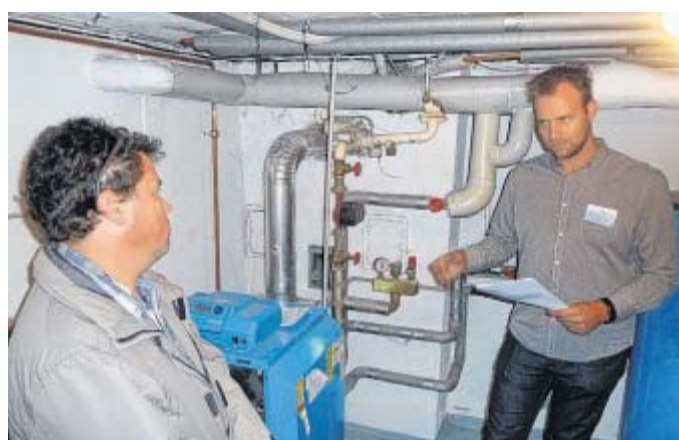
Heizungsvisite: Die Energieberater Sven Rauscher (r.) und Oliver Vredenburg bei einer Begutachtung im Heizungskeller.
